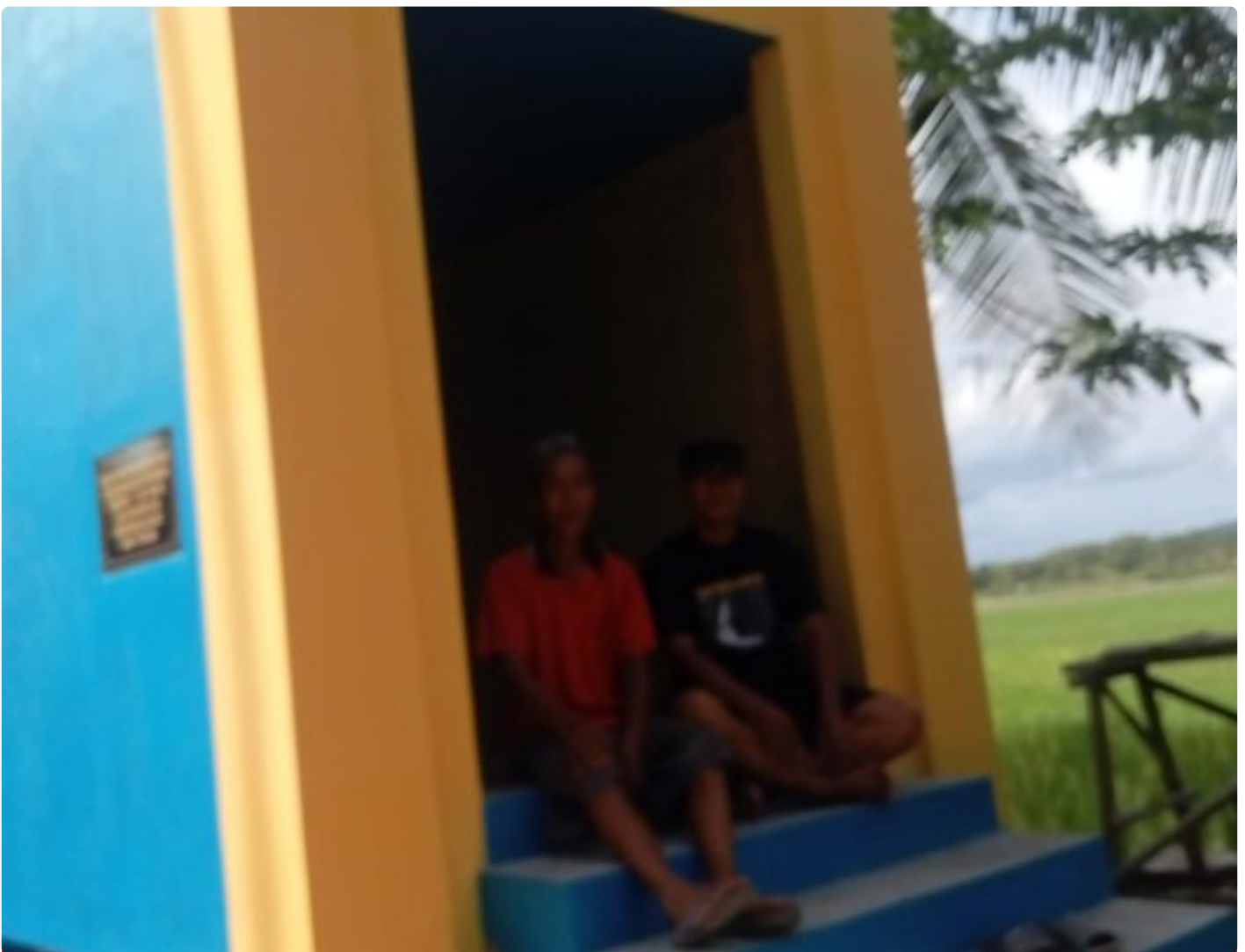
Pembangunan Irigasi Perpompaan di Desa Binangun
